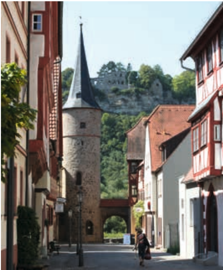
Blick in eine der historischen Gassen Karlstadts hin zum Maintor.
